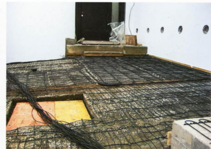
Die „Fußbodenheizung“ im Eingangsbereich wird verlegt.
