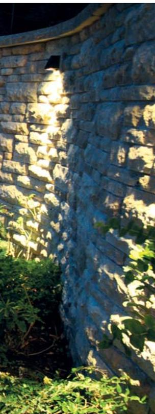
Die Betonmauer nach der Steinverblendung.
