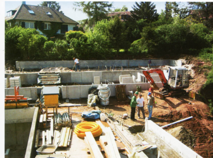
Die „Stockwerke“ wurden mittels Beton-L-Steinen gebaut und später durch Buchs- und Taxus -Hecken verblendet.
