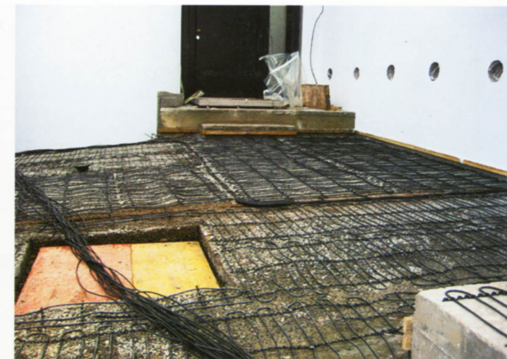
Die „Fußbodenheizung“ im Eingangsbereich wird verlegt.
